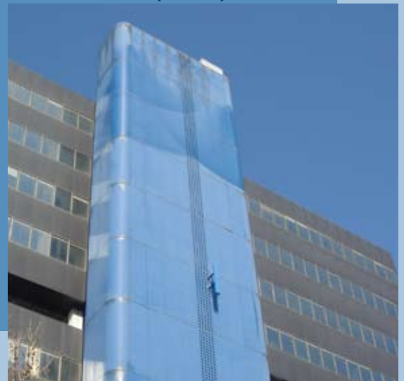
D - Deposito esterno a zaino appoggiato all'edificio principale
