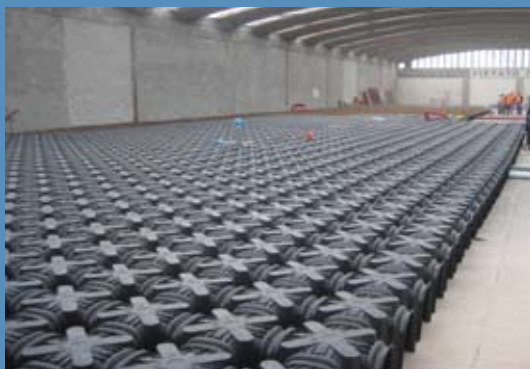
Platea di deposito
